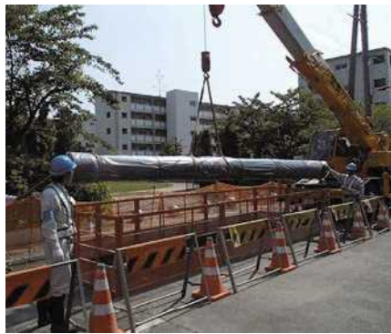
水道管路の取替工事の様子
